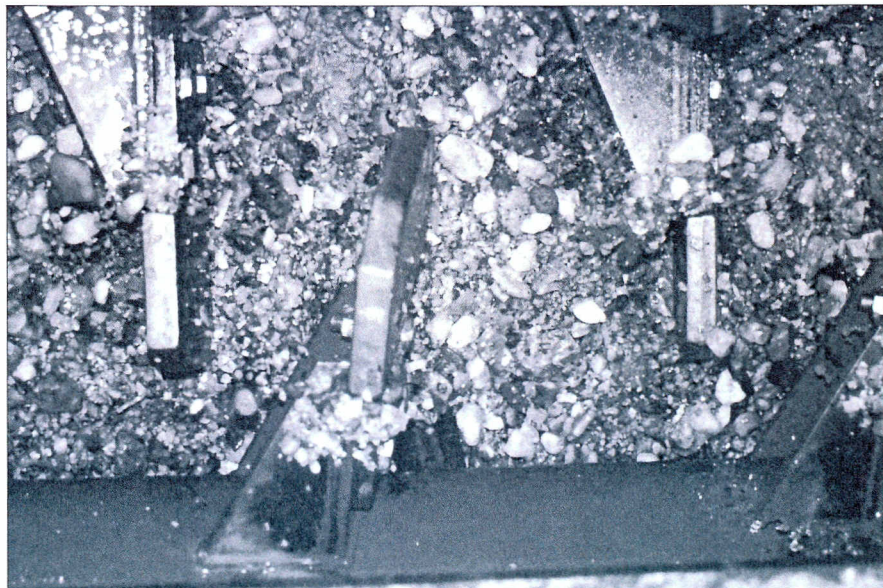
Interior de un lavador de piedras en funcionamiento.
