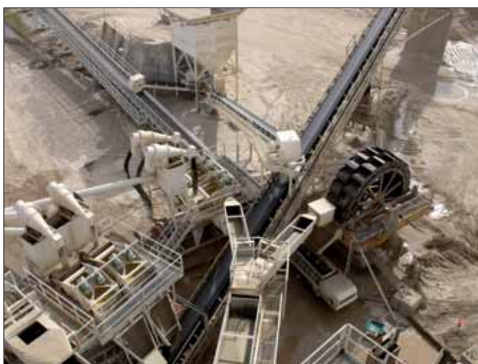
Figura 7.- Vista aérea de equipos de lavado de arenas.
