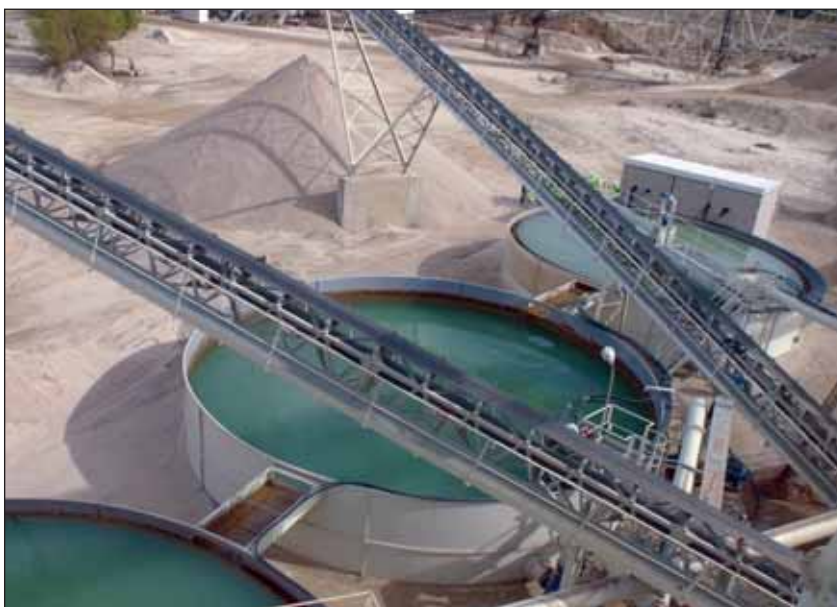
Figura 10.- Decantadores y tanque de aguas limpias.
