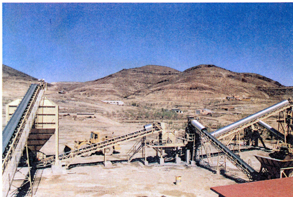
Vista general de la instalación desde el puesto primario.
