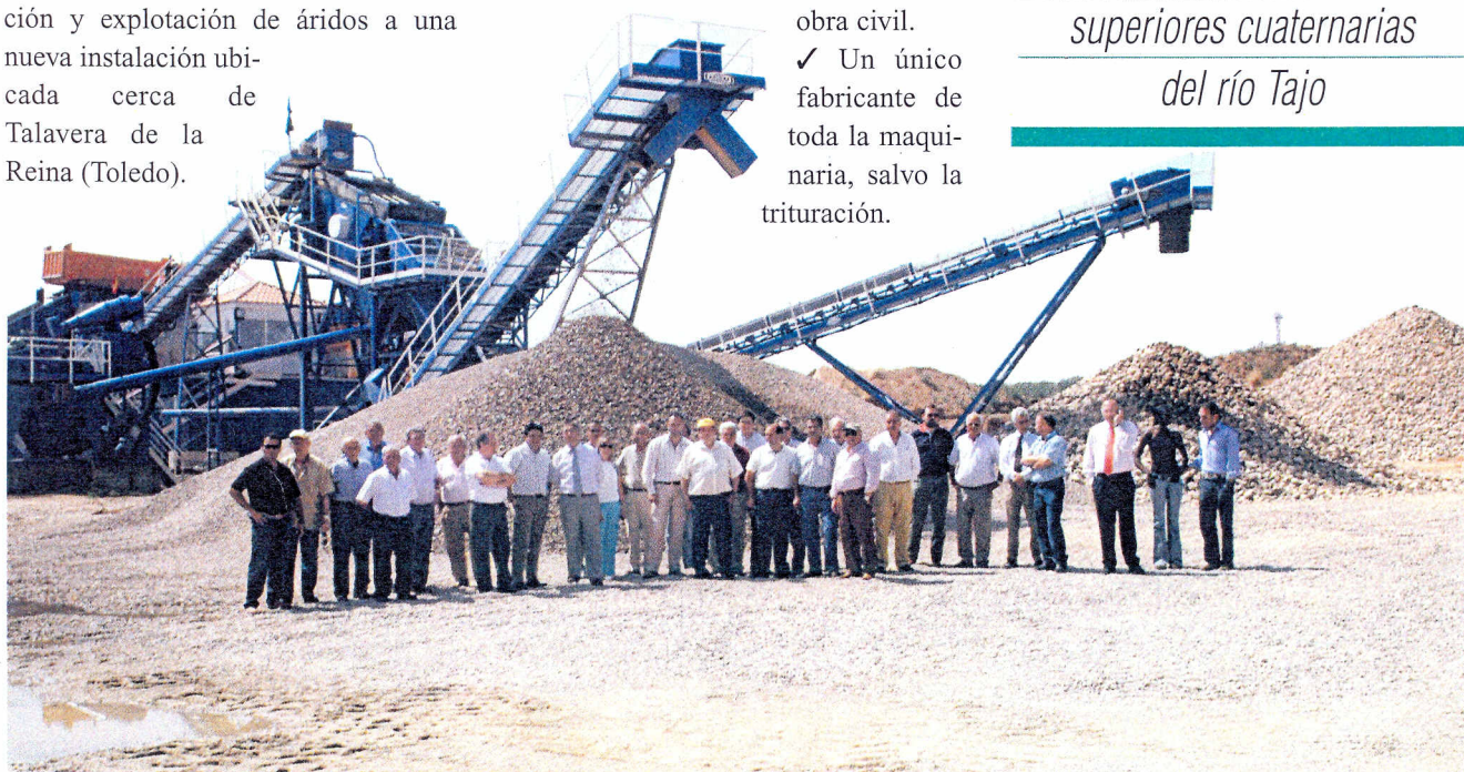
Figura 1.- Inauguración de la planta - Vista general.
