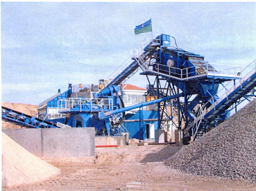
Figura 4.- Instalación vista desde los stocks finales.
