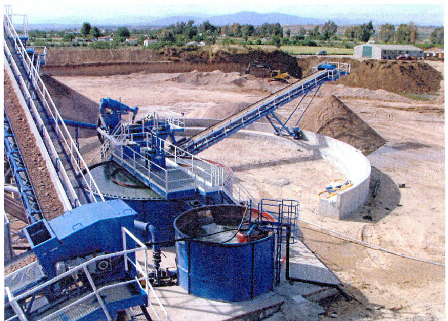
Figura 5.- Lavado y acopio de arenas con decantador.
